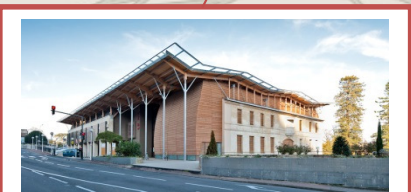
BÂTIMENT DU NIL 138, rue de Bordeaux
